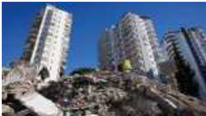
Рис. 4. Разрушенное здание в Кахраманмарасе
