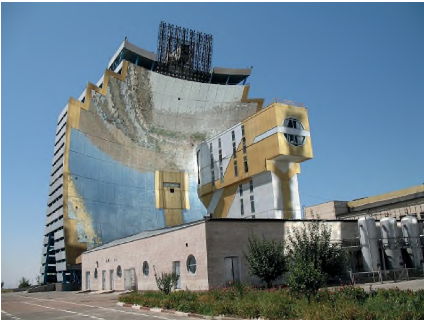
Экспериментальный блок Большой солнечной печи (БСП, Паркент, Узбекистан)
