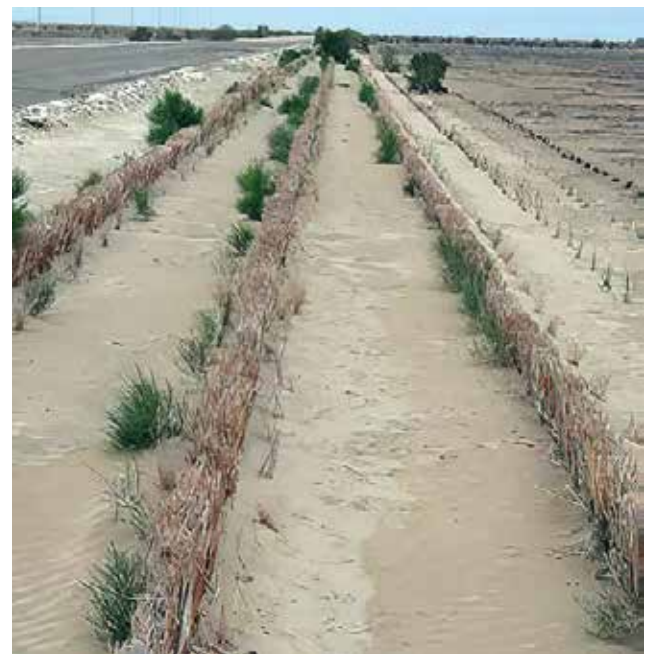
Посадка сеянцев саксаула вдоль механических защит
