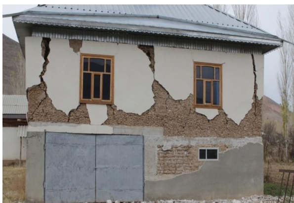
1.9 - расм. Зилзила оқибатида дераза оралиқларида вужудга келган диагонал ва горизонтал ёриқлар
