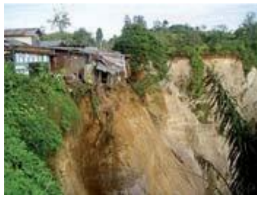
1.2 - расм. Ер ўпирилишидан биноларнинг зарарланиши
