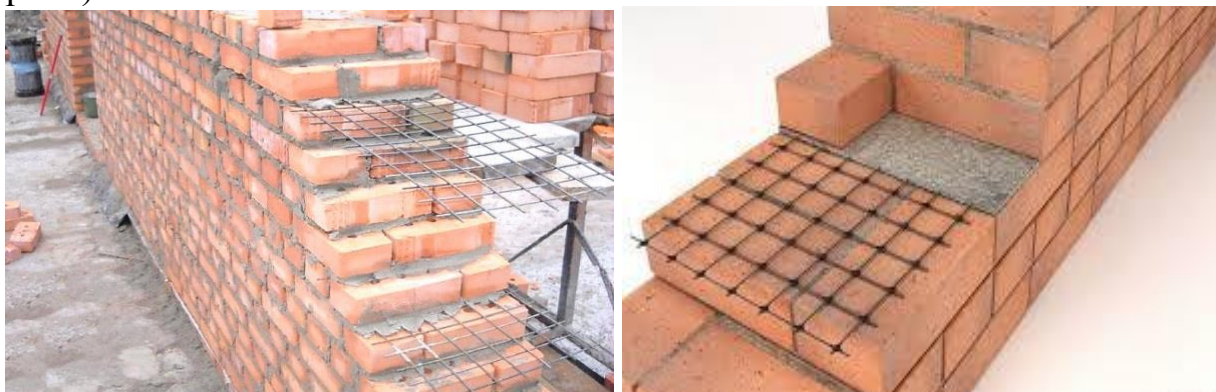
4.2 - расм. Ғиштли деворларнинг арматуралаш
